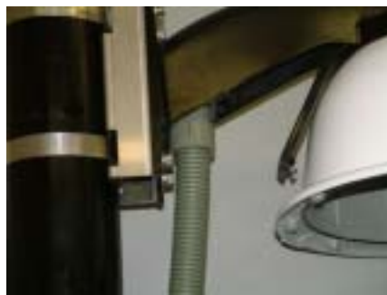
FP 管 CD 管をアームに直接取付ける時はアーム部の穴をご使用下さい
